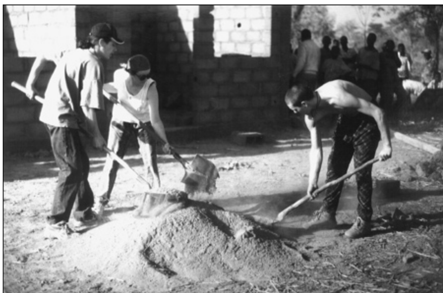
◀ Chantier du Lycée Théodore Deck, Burkina-Faso, J. LASLAZ.
